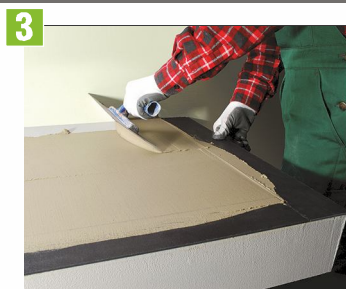
Układamy zaprawę wyrównawczą do wysokości szablonu.
