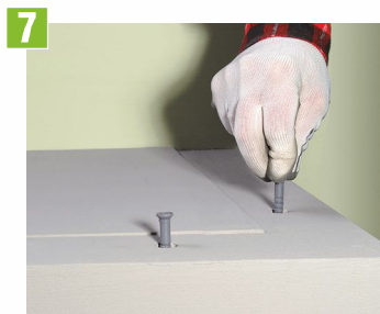
Montujemy koszulki kołków rozporowych w przygotowanych otworach.
