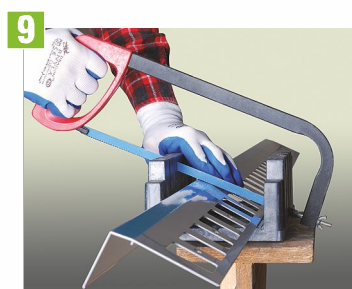
Przycinamy profile proste K301 na wymiarzoną wcześniej długość.
