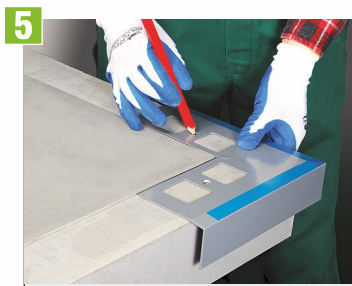
Zaznaczamy otwory pod kołki rozporowe do montażu profili narożnych.
