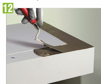
Rozkładamy zaprawę uszczelniającą pod montaż profili.
