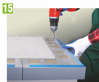
Po wstępnym związaniu zaprawy uszczelniającej dokręcamy wkręty kołków rozporowych.
