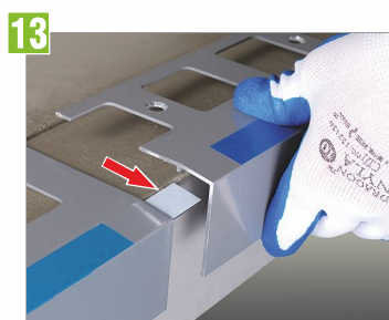
Na łączeniach profili mocujemy poziome łączniki dylatacyjne.
