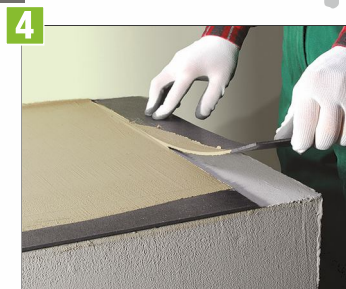
Usuujemy szablon i czekamy aż zaprawa stwardnieje.
