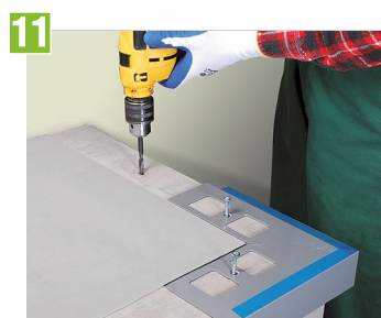
Wiercimy otwory i montujemy koszulki kołków rozporowych w otworach.
