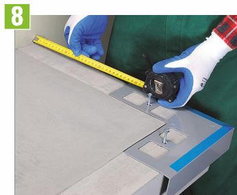
Wstępnie montujemy profile narożne, wymierzamy profile proste (pozostawiamy na łączeniach profili przerwy dylatacyjne o szer. 2 mm).
