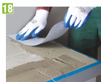
Wzdłuż wew. krawędzi profilu, na styku z podkładem cementowym układamy zaprawę uszczelniającą a następnie wtapiamy w nią taśmę wzmacniającą.
